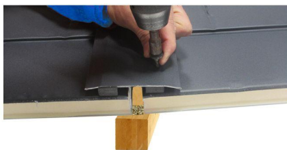
Atornillamos remate con tornillos de cosido de remates
