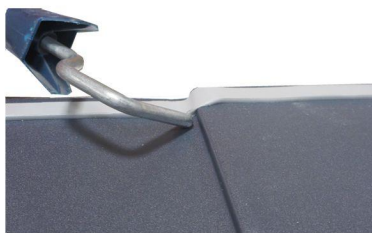
Comprobacion que los pliegues del panel quedan sellados.
