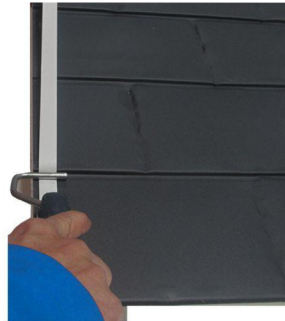
Presión del cordón butilo sobre todo en los pliegues del panel para asegurar estanqueidad
