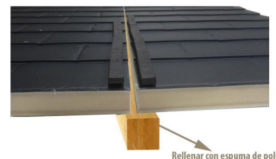
Rellenamos el hueco de la unión con espuma de poliuretano hasta la mitad.
